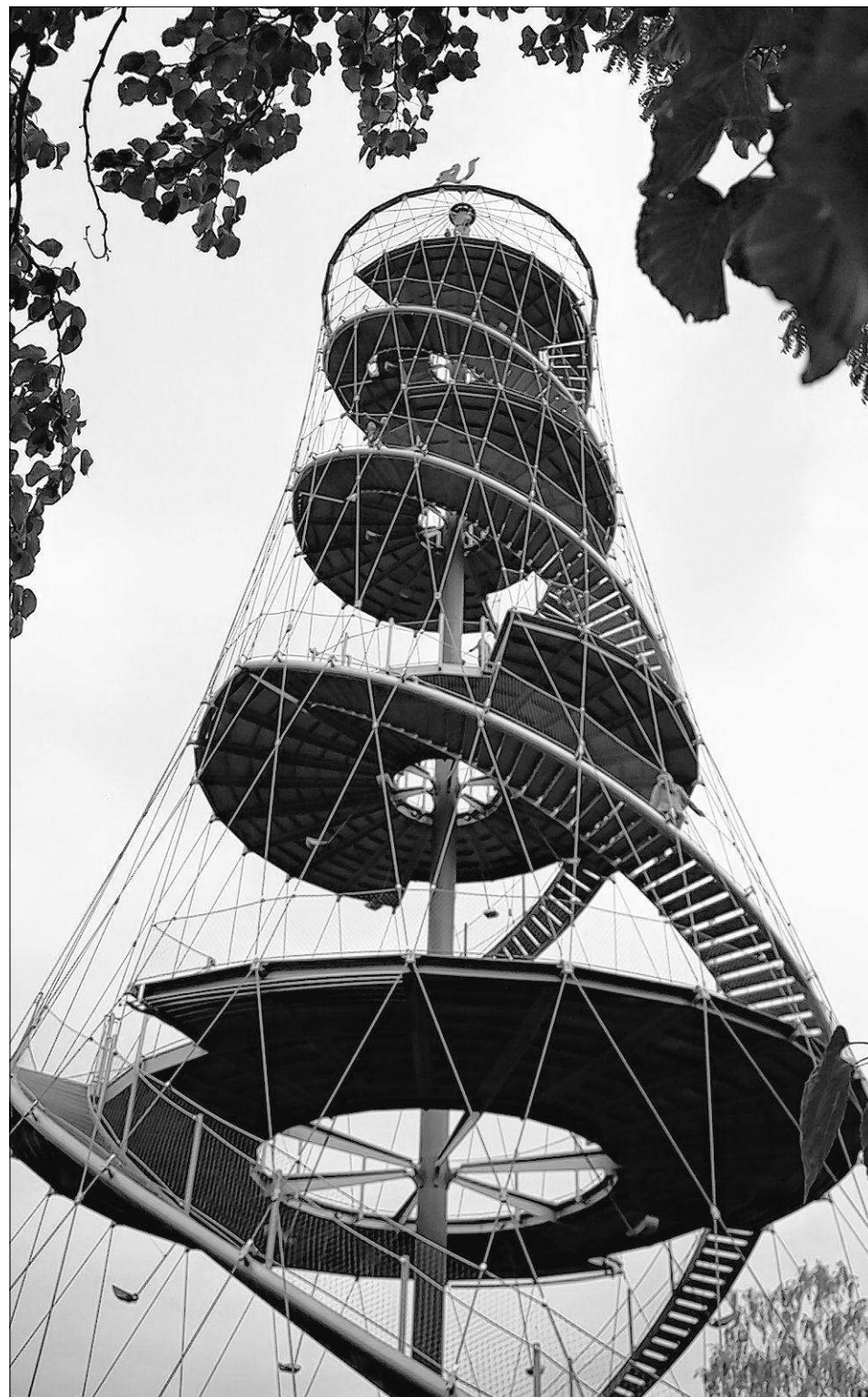
Der Killesbergturm des Verschönerungsvereins Stuttgart wurde am 17. Juli 2001 eingeweiht. Ohne die vielen Spenden wäre der Bau unmöglich gewesen.
